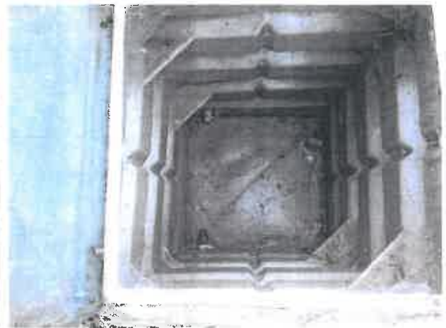
vízóra akna, beállítás
